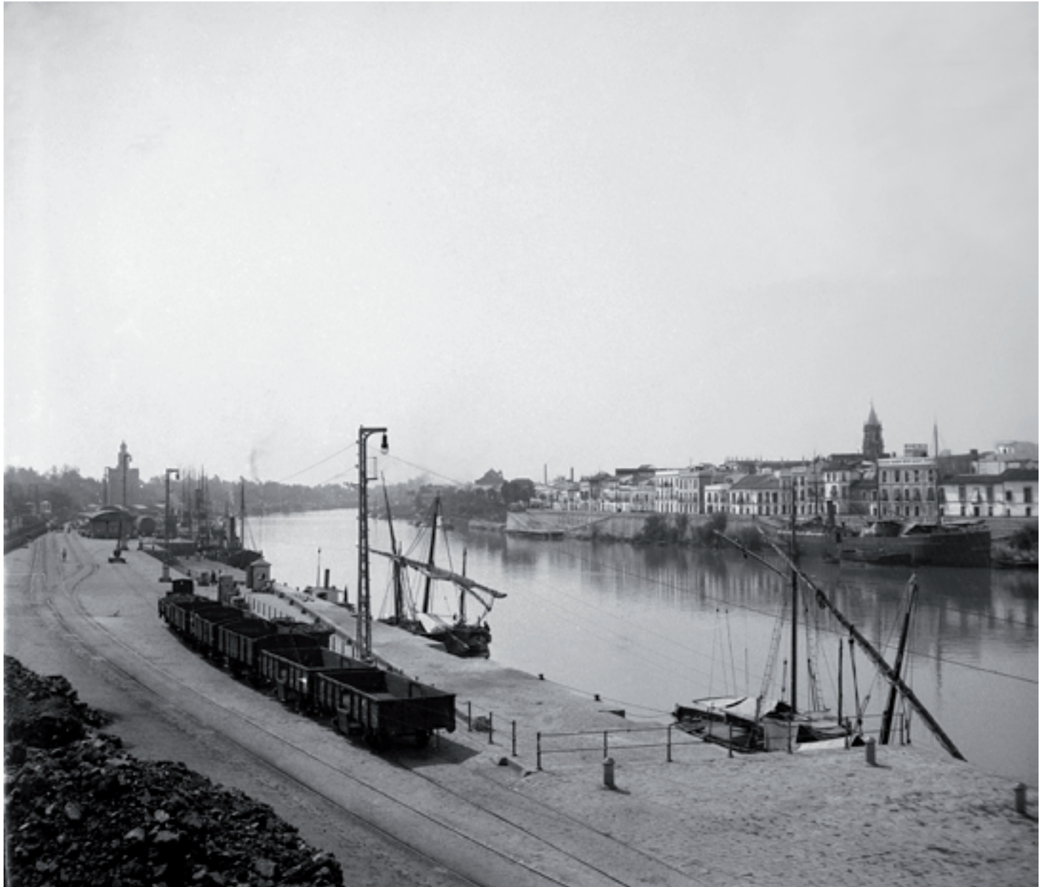
Antiguo Puerto de Sevilla, Sevilla h. 1926
