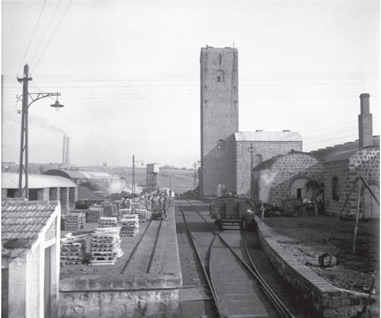
Fundición La Tortilla, Linares, Jaén h. 1920
