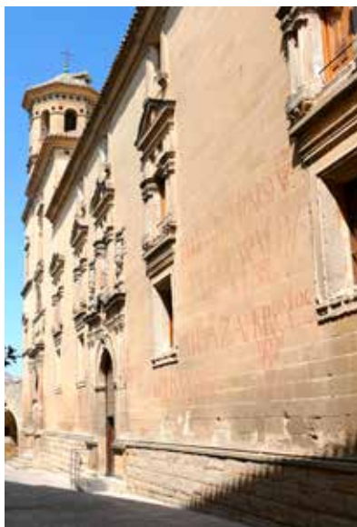
Foto 1.-Vista general Universidad.
